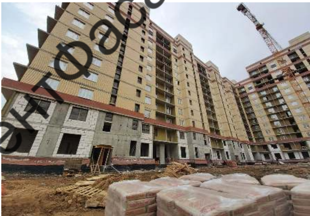
Рис. 2 Общий вид объекта
